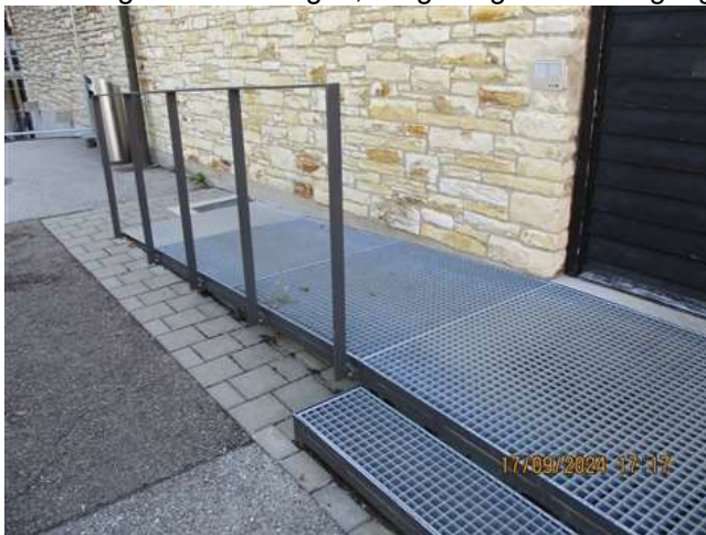
Provisorisches Eingangspodest O28
