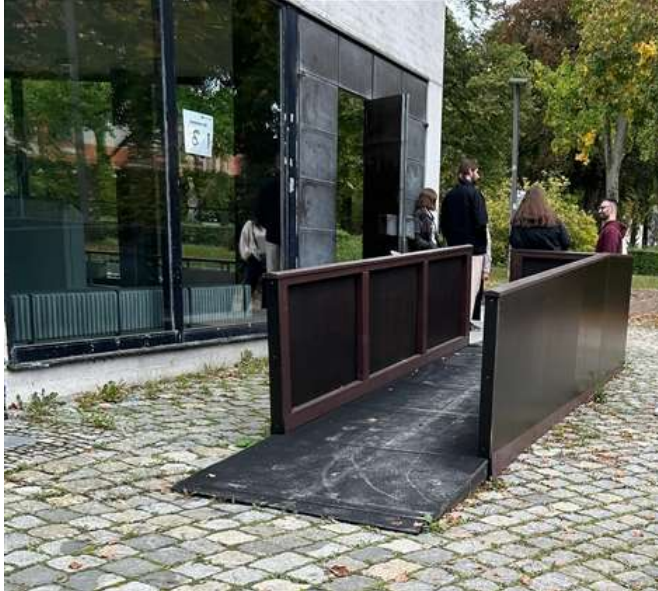
Provisorisches Eingangspodest KGD
